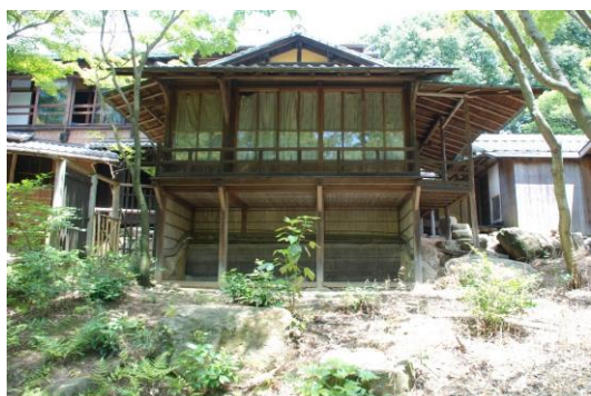
南東棟の外観
